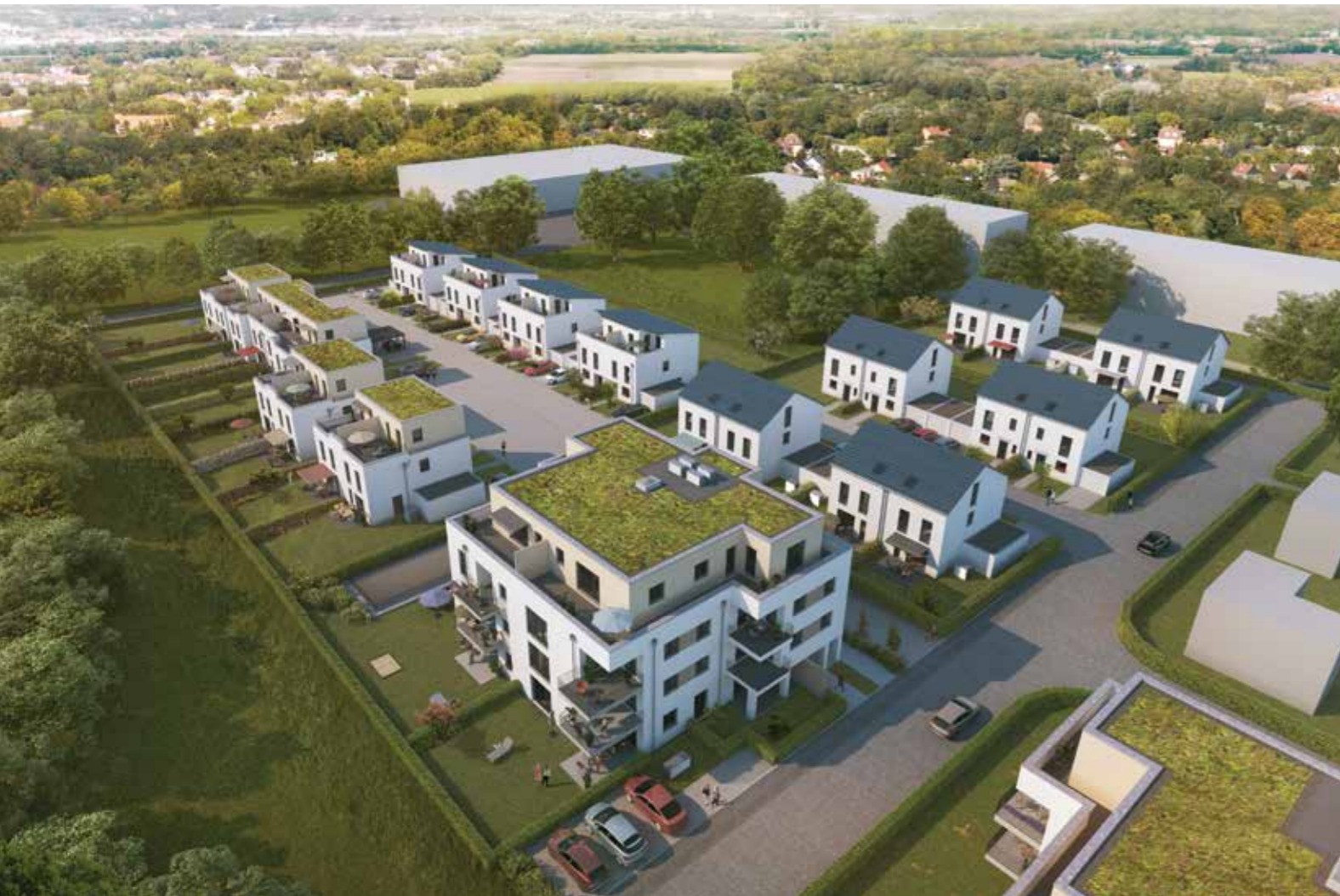
Der Startschuss mit dem 1. und 2. Bauabschnitt
